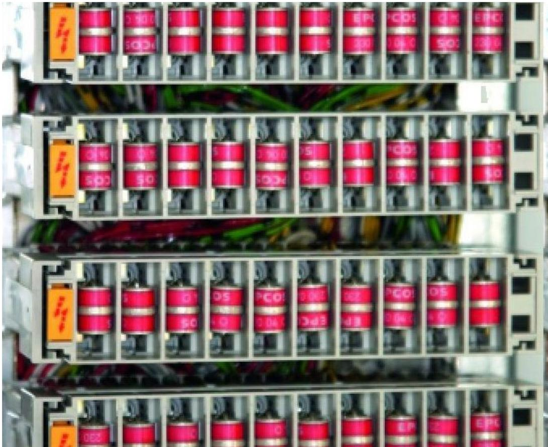
Zur Prüfung kann man jedes einzelne Magazin entnehmen
